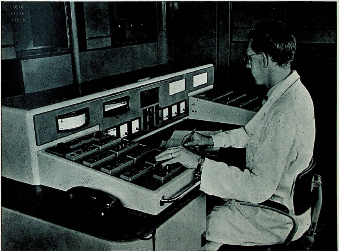
Een blik op de bedieningslessenaar van de nieuwe kortegolfzender, die Philips voor de wereldomroep bouwde, met de technicus, die moet zorgen, dat alles goed gaat. Door middel van de tientallen meters en lichtjes krijgt hij onmiddellijk een overzicht van de gang van zaken in de zender.
